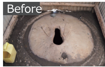
◀ 蓋がなく、悪臭がひどい従来のトイレ
