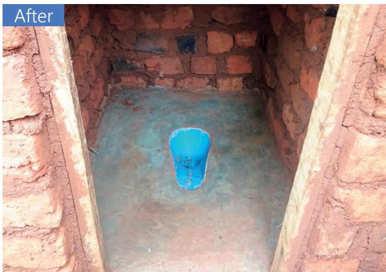
▲ 地面に掘った穴に SATO を取り付け、周囲の床をセメントで固めたことで、水を流せるように
